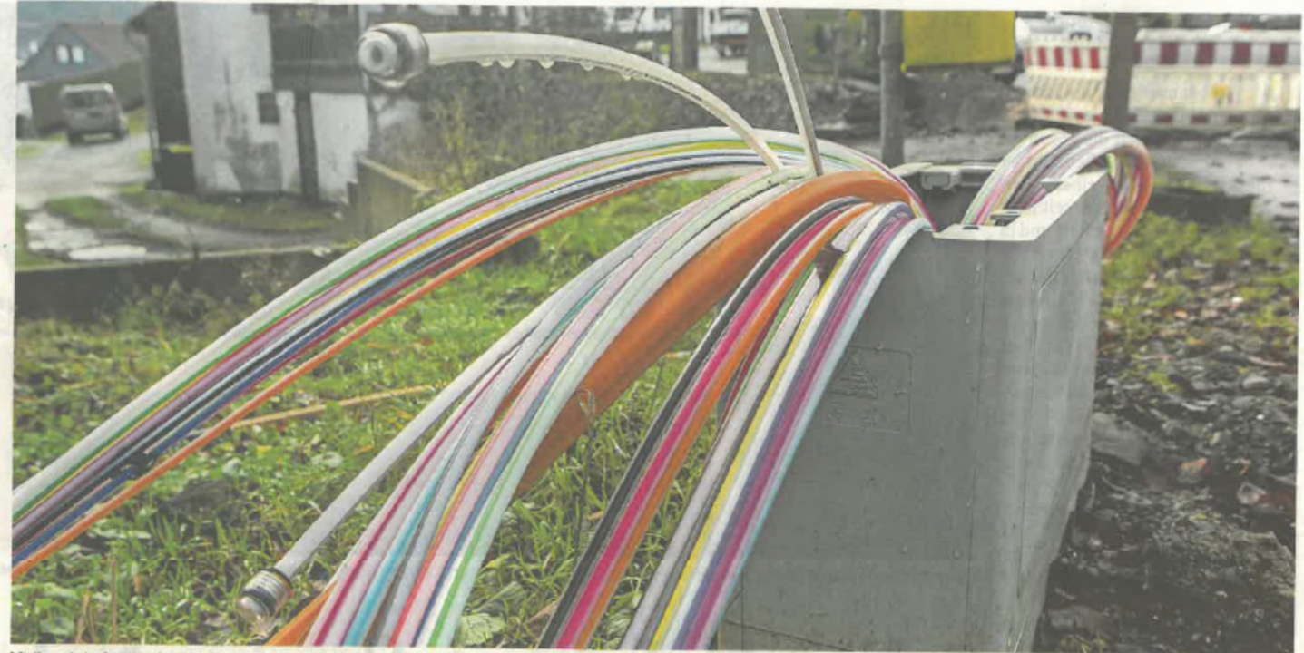
Meilenstein für die Jagsttalgemeinde: Ein Glasfasernetz zum Breitbandausbau sorgt künftig in Mulfingen für schnelles Internet.
